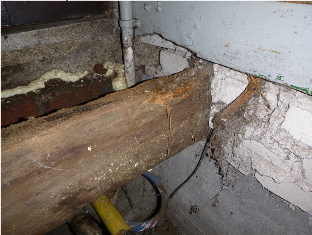
Foto 4: balk is aangetast door bruinrot en zwam.
