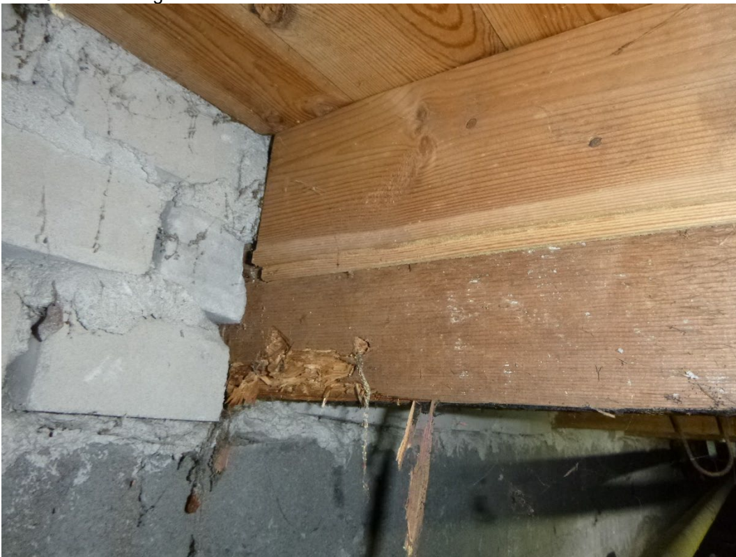
Foto 6: balk is aangetast door bruinrot.
