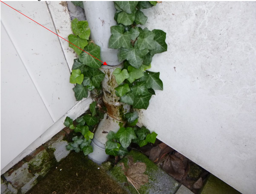
Foto 8: lekkage hemelwaterafvoer.
