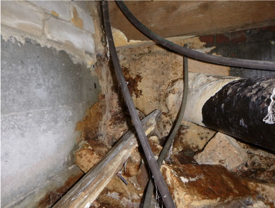
Foto 8: lekkage hemelwaterafvoer.
