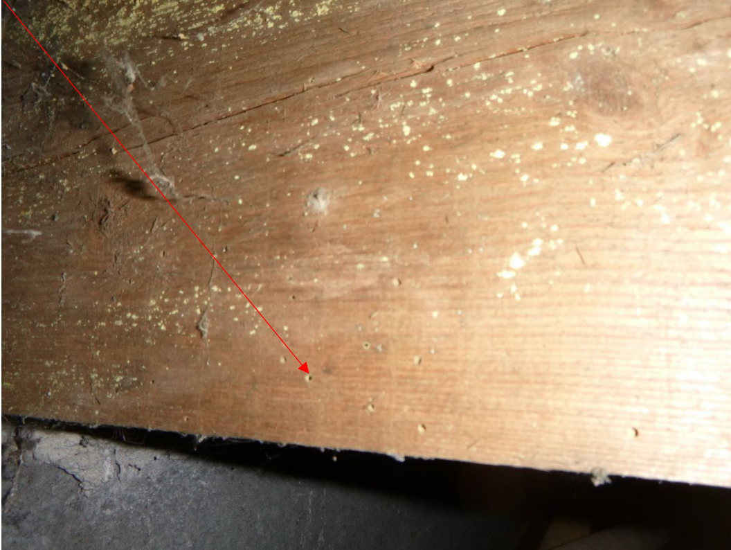
Foto 4: balk is aangetast door bruinrot en zwam.
