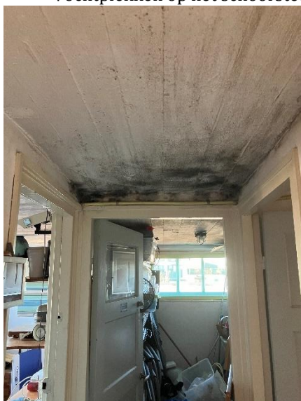
Schimmelvorming op het plafond in de hal en de naastgelegen berging
