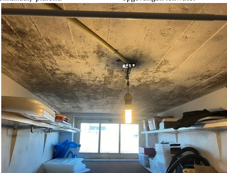
Schimmelvorming op het plafond in de hal en de naastgelegen berging
