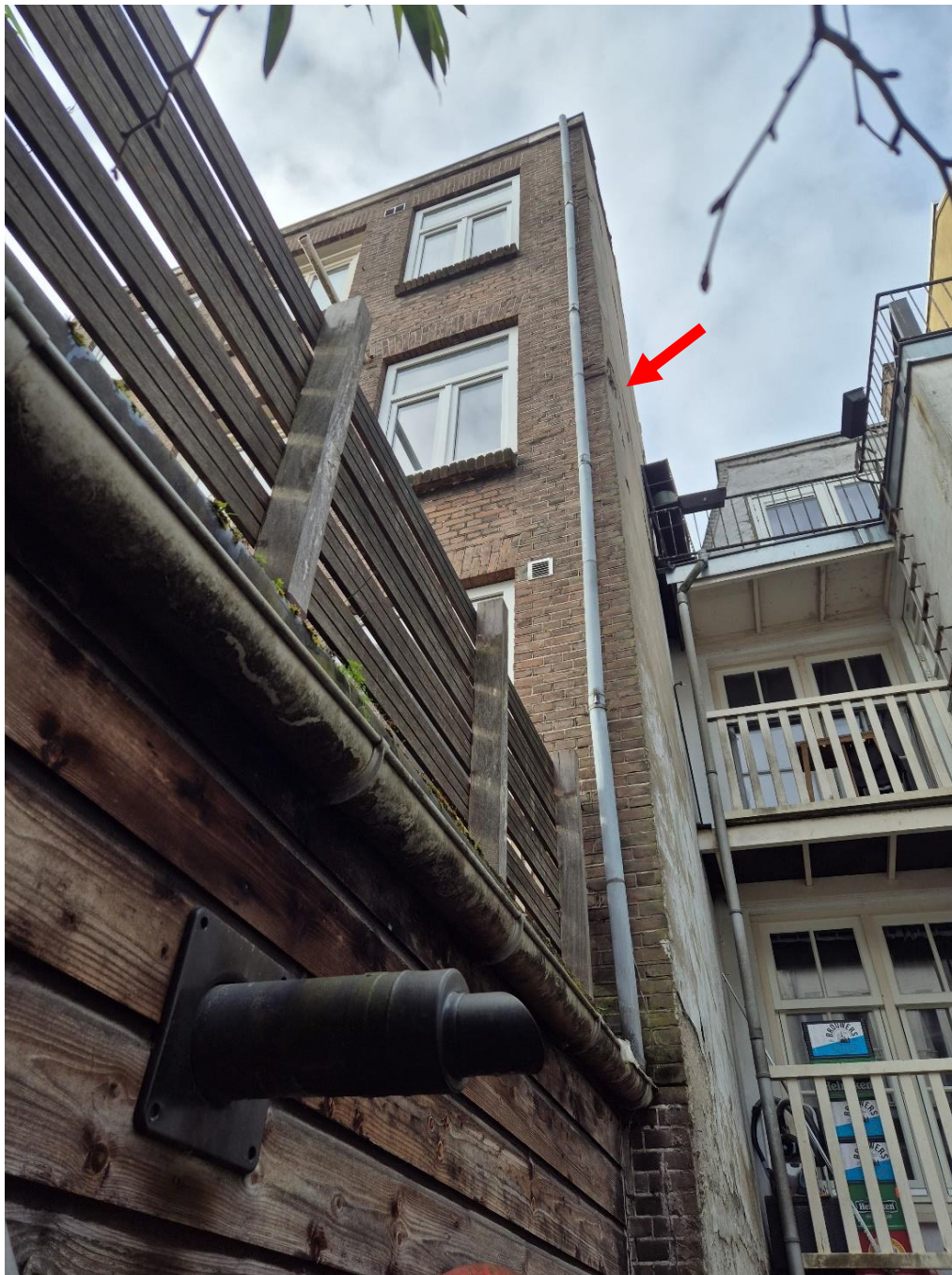
Afbeelding 25: een ander deel van de achtergevel en de zijgevel
