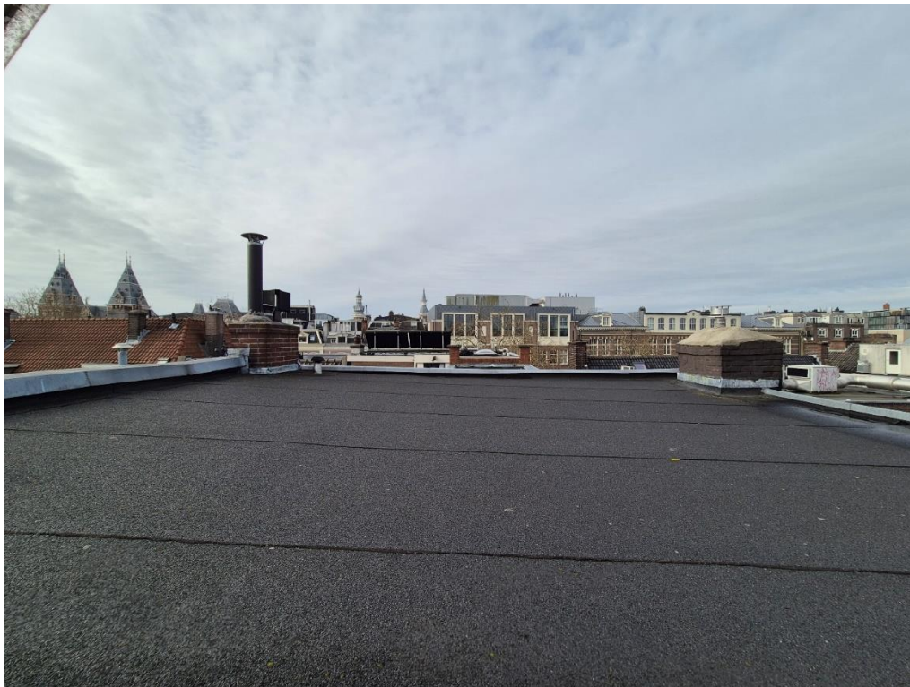
Afbeelding 31: platdak recentelijk voorzien van een nieuwe dakbedekking
