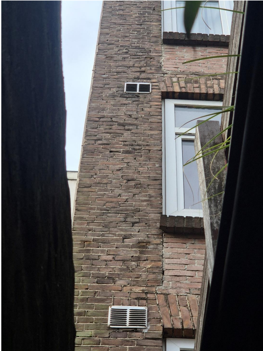
Afbeelding 24: deel van de achtergevel
